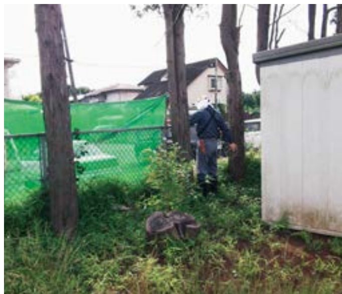
作業前に防護ネットを張る
